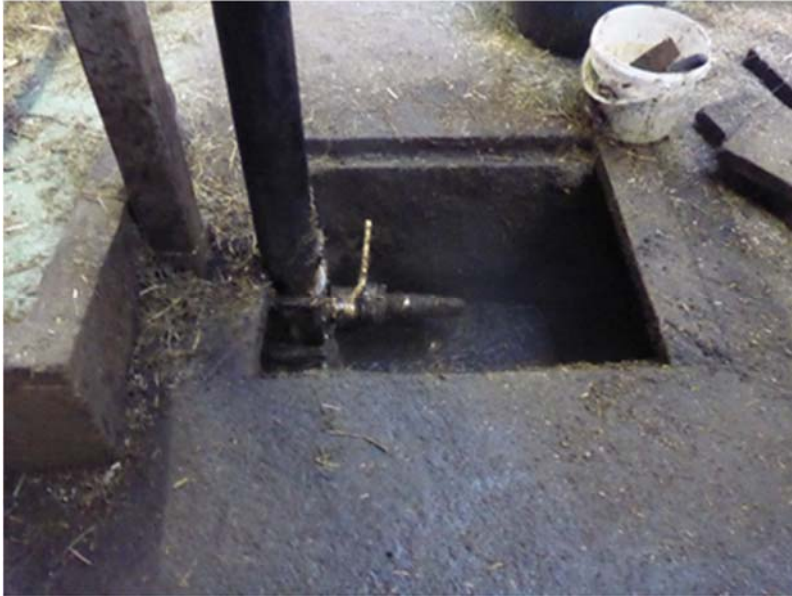
Abbildung 2: Öffnung im Kuhstall für das Einspeisen von Mist, Gülle und Cosubstraten (Bild: Matthias Meier, FiBL)
