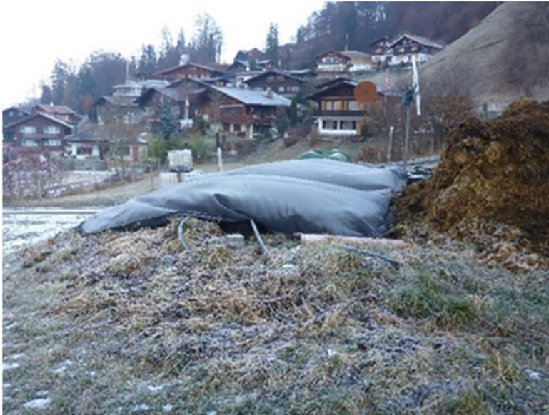
Abbildung 3: Gasballon für die Biogas-Speicherung (Bild: Matthias Meier, FiBL).
