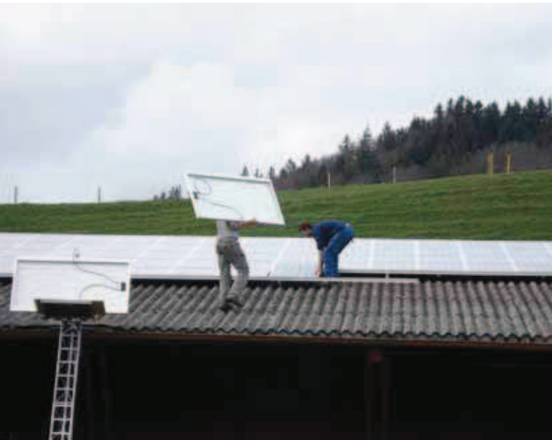
Ende März 2008 wurden 160 Quadratmeter Solarmodule auf dem Dach von Scheune und Stall montiert.
